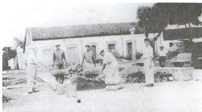
Primeras calles pavimentadas alrededor del Parque Central de Jalapa
