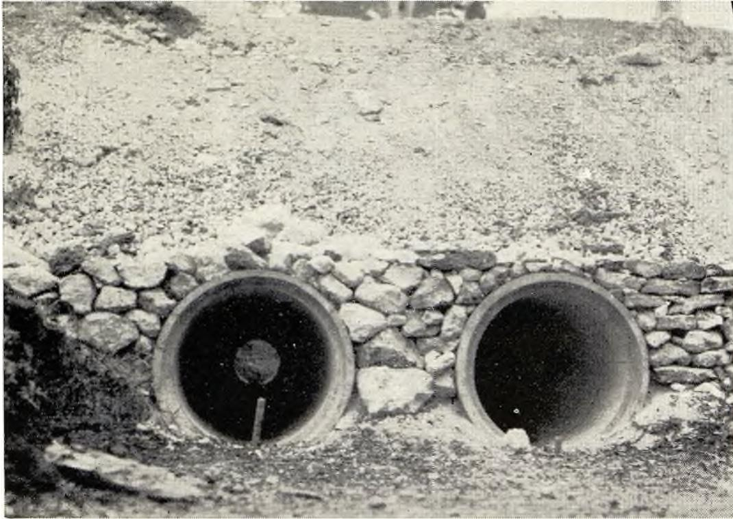
Alcantarillas.—Alcantarilla de tubos de concreto con muros de cabeza de piedra acomodada.
