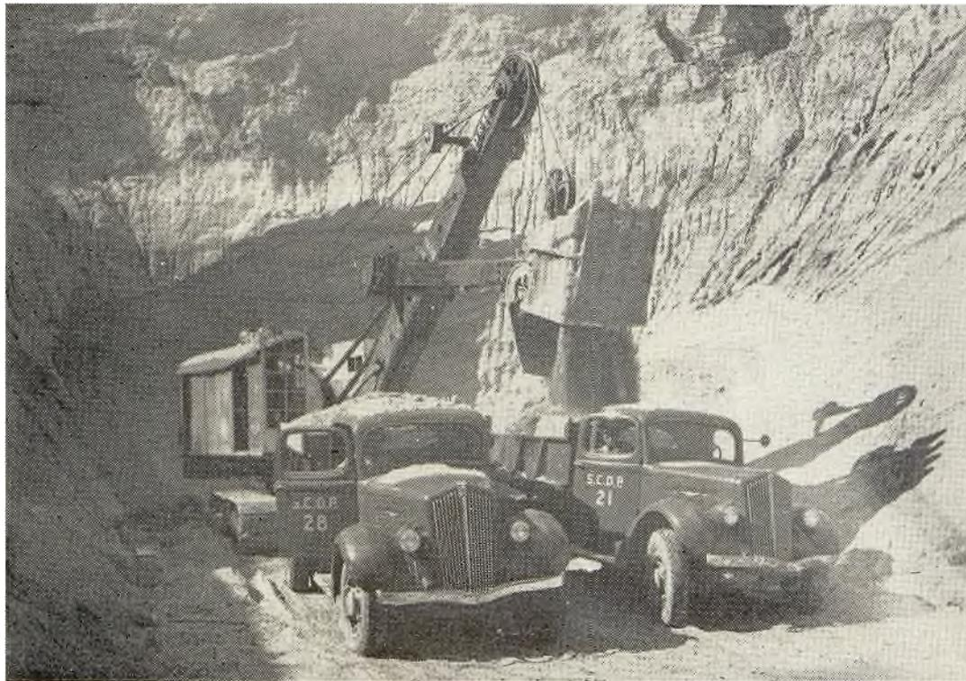
Una pala sobre orugas, carga una flotilla de camiones de volteo en el ataque de un tajo.
