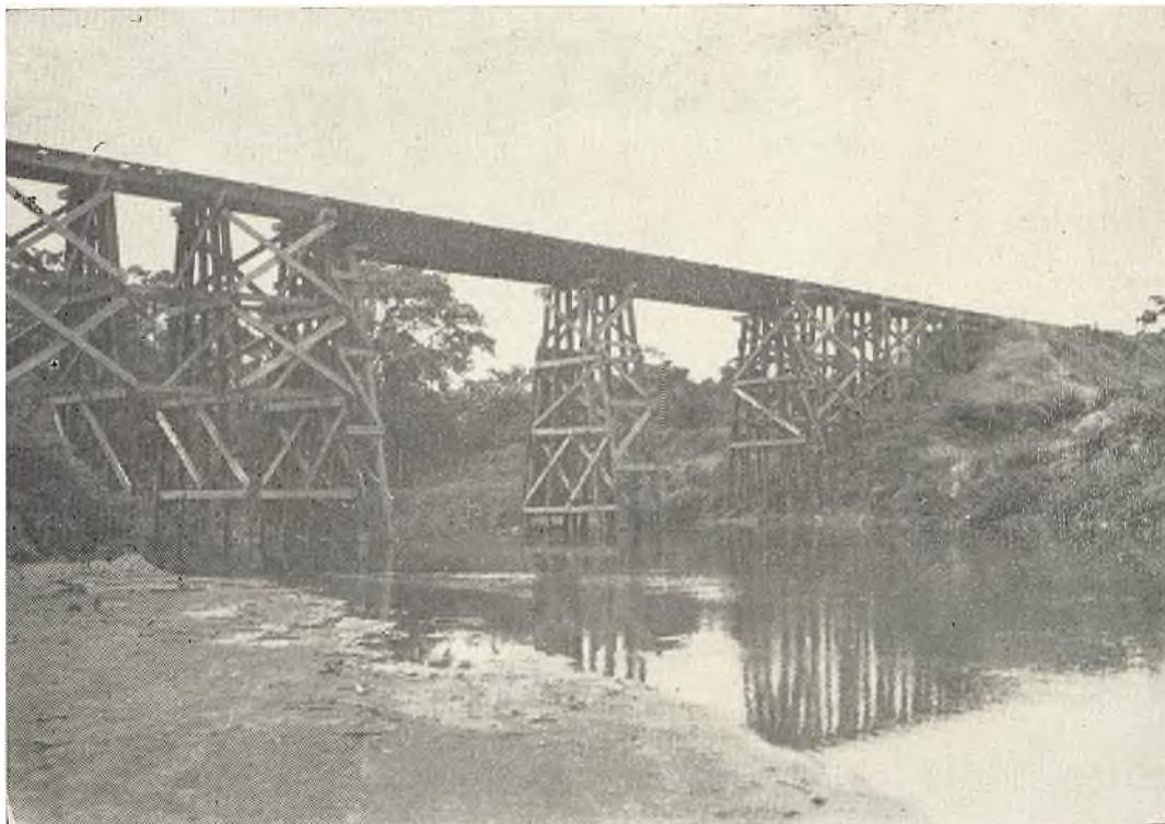
Puentes Provisionales.—Puente de bancos dobles de pilotes, de gran altura, para soportar traveses remachados de acero de 15 a 20 metros de claro.
