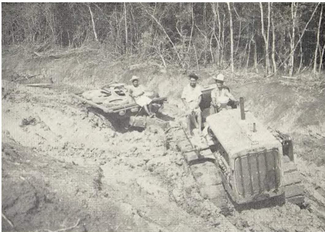
Transportes Terrestres.—En la temporada de lluvias los tractores prestaron inestimable utilidad en el transporte de combustible, lubricantes y refacciones para las máquinas excavadoras.
