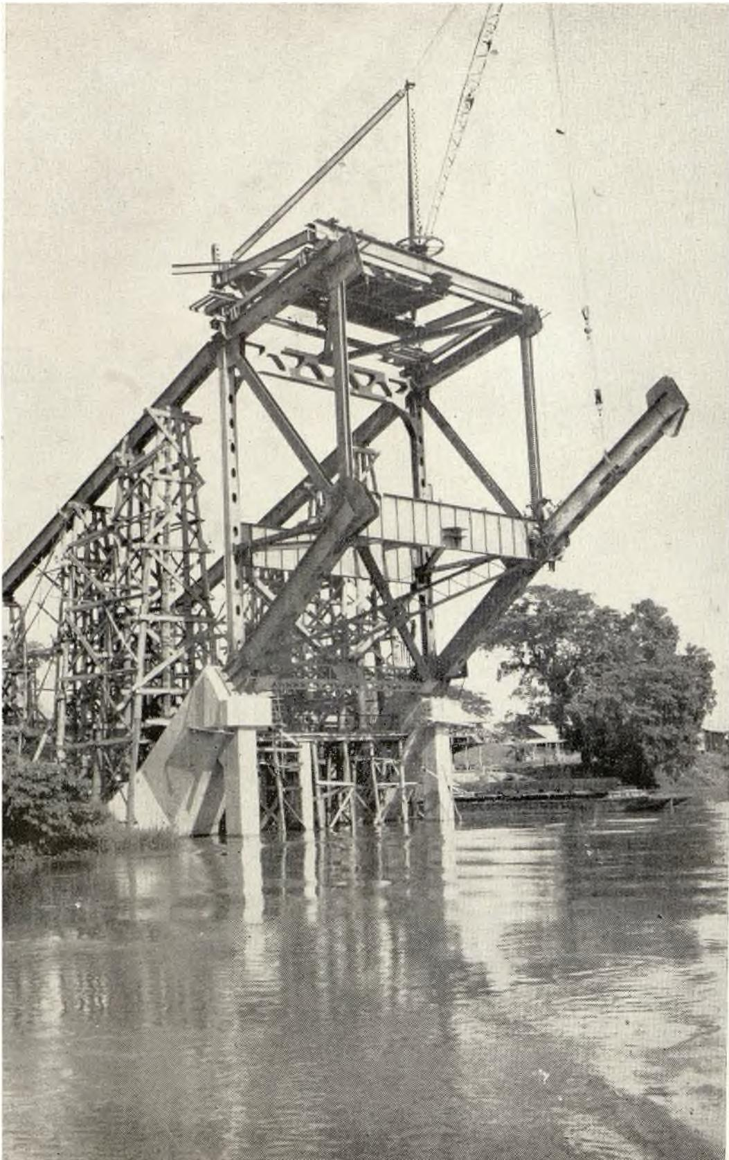
Puente Usumacinta, Km. 396.—Erección de un miembro de la cuerda inferior del arco.
