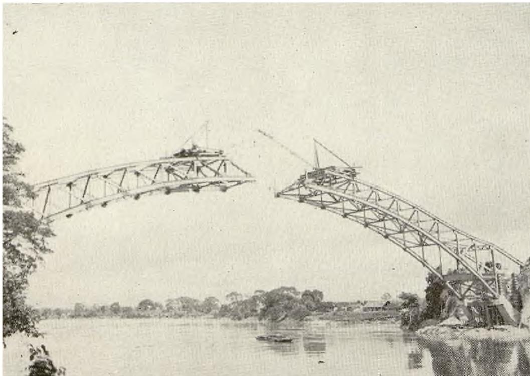
Puente Usumacinta, Km. 396.—Montaje en cantiliver de las armaduras en arco. La alimentación de las grúas se hizo desde el río, mediante chalaques.
