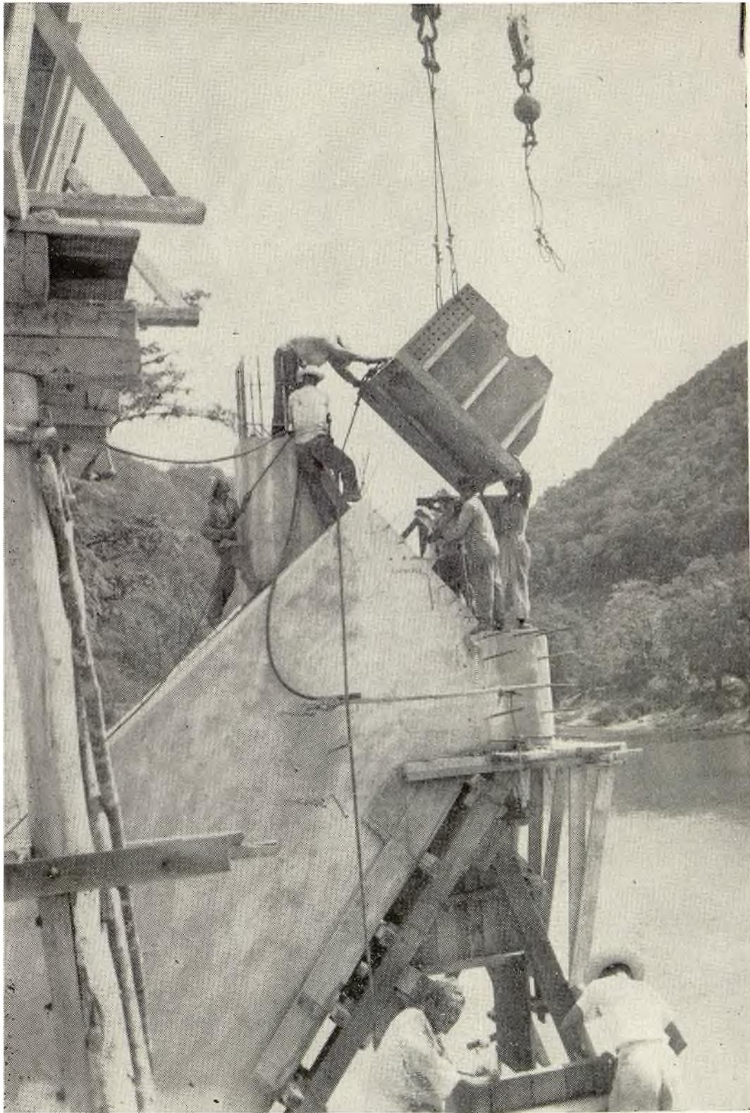
Puente Usumacinta, Km. 396 —Colocación de una zapata del arco sobre el correspondiente pedestal de concreto, que trasmite las cargas al terreno.
