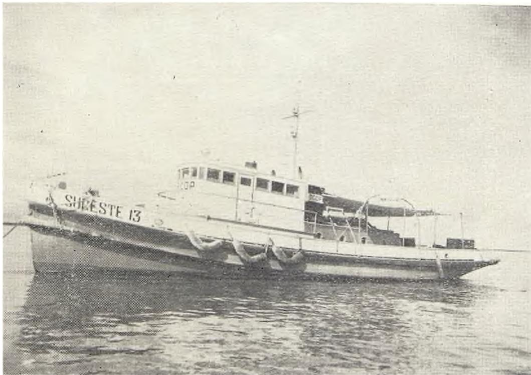
Transportes Marítimos.—Remolcador SE-13 para alta mar, con velocidad de 12 millas por hora sin remolque y capacidad para tirar un chalán con 300 toneladas de carga.
