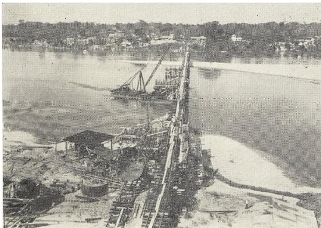
Vista general del puente provisional y de la obra falsa necesaria para el colado y el hincado de los cilindros de cimentación.
