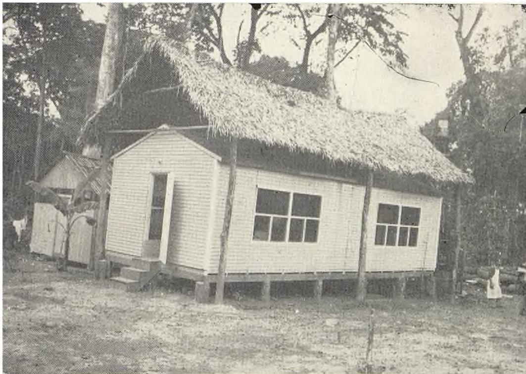
Edificios.—Casa de madera desarmable, portátil, para campamentos de construcción.
