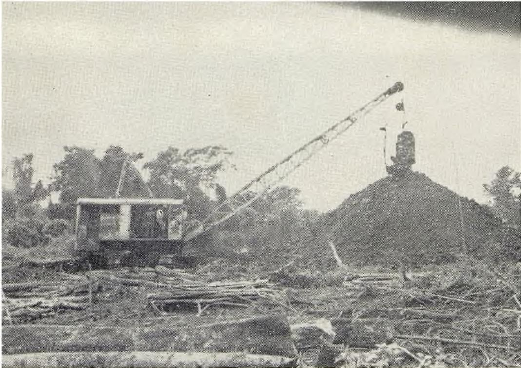
Las pesadas dragas requerían frecuentemente un piso de troncos de árbol, para no hundirse en los terrenos fangosos.
