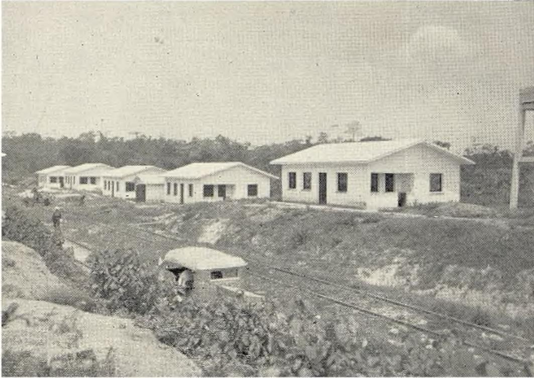
Edificios.—Casas con muro de tabique recocido y techos de concreto reforzado, para habitación de las cuadrillas de conservación.
