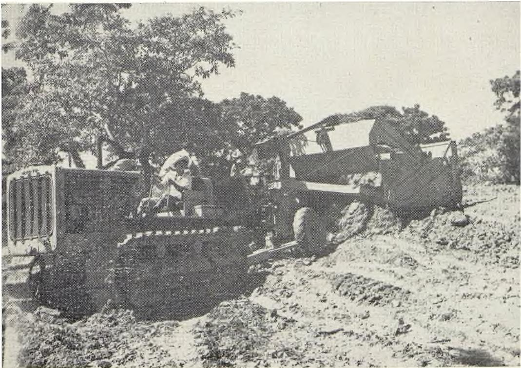
Se empleó el equipo más moderno en el movimiento de terracerías. Un tractor RD-7 tira una escarpa de gran capacidad montada sobre llantas neumáticas.
