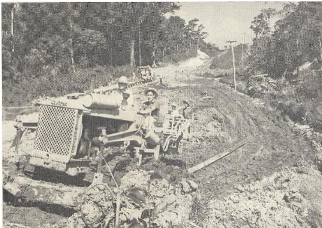
Transportes Terrestres.—Un Bulldozer desprovisto de la cuchilla de empuje, auxilia en el arrastre de rieles en un tramo difícil. Al fondo un tren de arzones para el transporte de material y personal.
