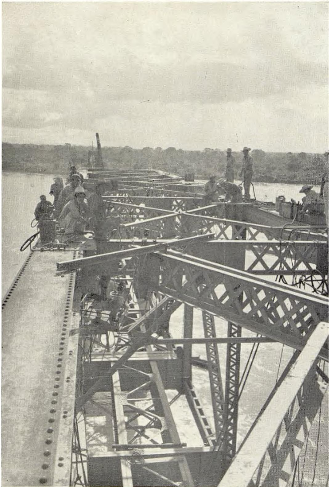
Puente Mezcalapa, Km. 145 -- Remachado del contraventeo superior de la armadura.
