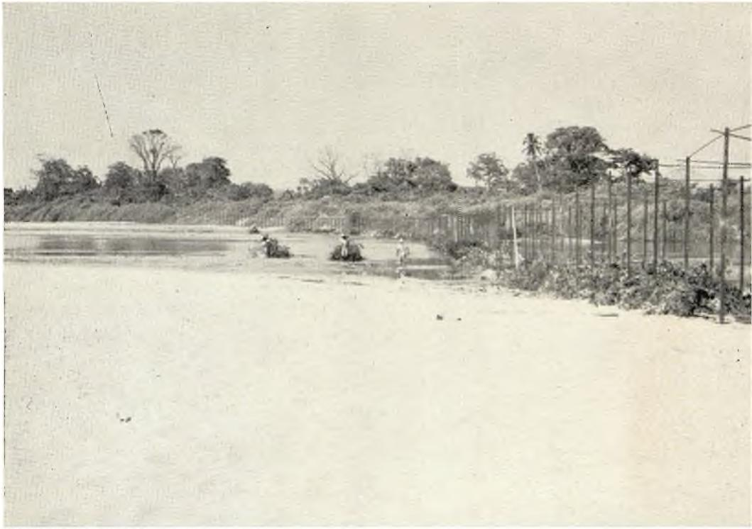
Río Mezcalapa, Km. 145.—Deralle de las barreras permeables construidas con varillas y rieles de pequeño calibre lastrados con bases de concreto; entre la doble hilera de rieles, se acomodó la ramazón que constituye en realidad el obstáculo colocado a la corriente.
