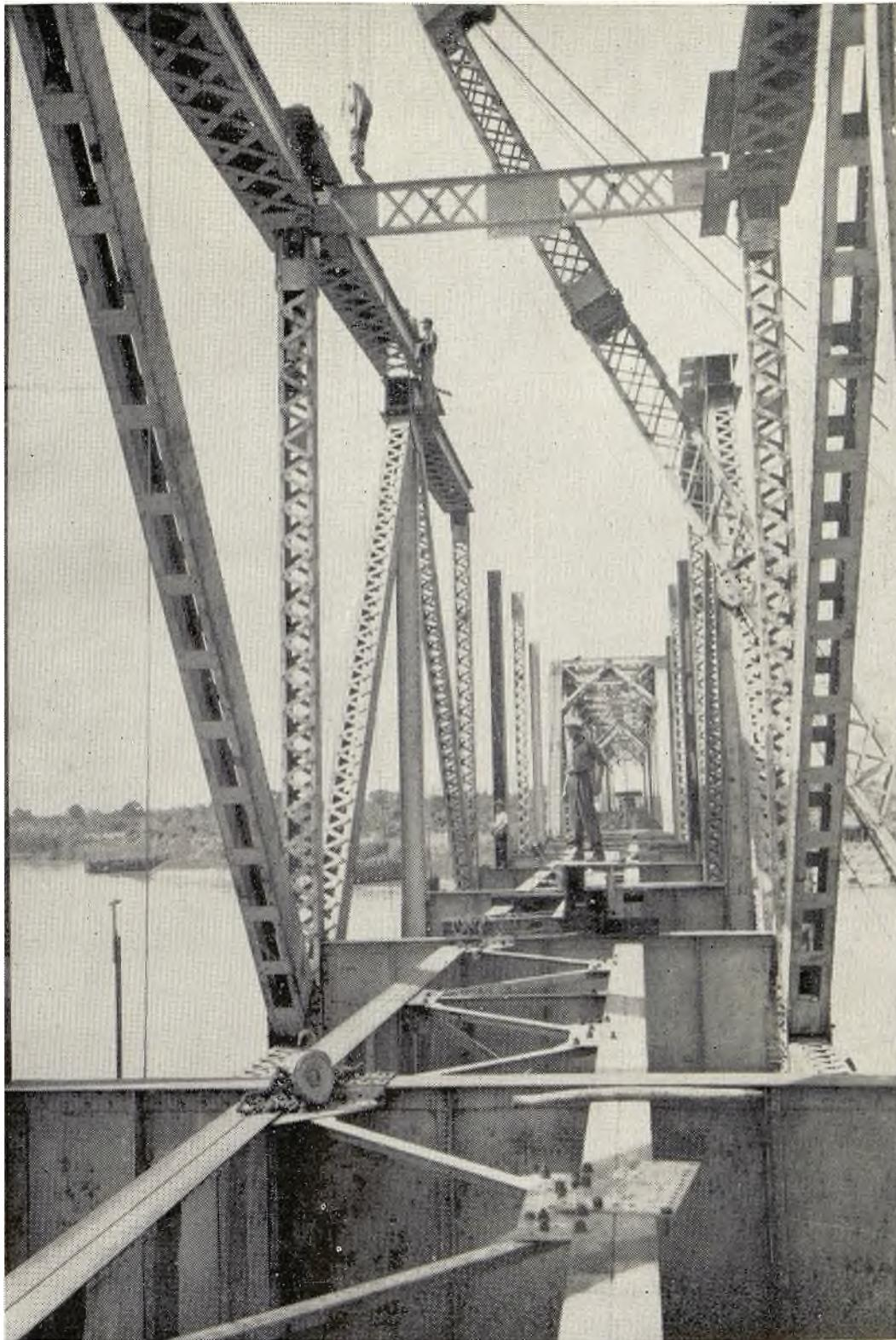
Puente Mezcalapa, Km. 145.—Montaje de las armaduras de acero de 70 metros de claro. Las grúas que se construyeron para erigir el Puente del Marqués en el Ferrocarril de Caltzontzin-Apatzingán, en el Estado de Michoacán, prestaron inapreciable ayuda en la construcción de los puentes de este ferrocarril, especialmente en los puentes de Tancochapa y Mezcalapa. En este último se utilizó una de ellas montada sobre chalanés.
