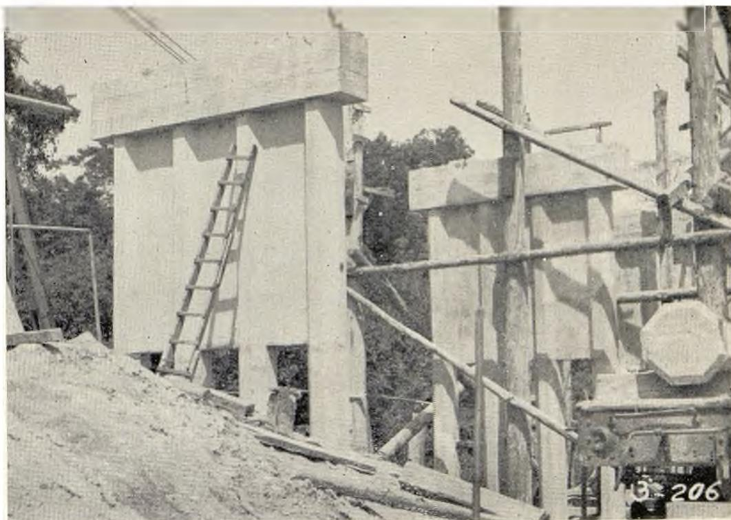
Puente Zanapa.—Fue necesario construir una obra falsa para fijar las guías y una espuela de vía para acercar los pilotes en plataformas y ponerlos al alcance de la grúa.
