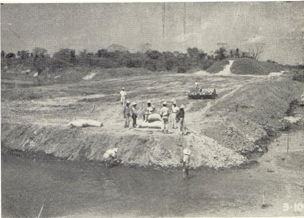
Cauce secundario del río Mezcalapa.—El terraplén que cegó el cauce El Chiflón fué construido por capas consolidadas con rodillos "pata de cabra".
