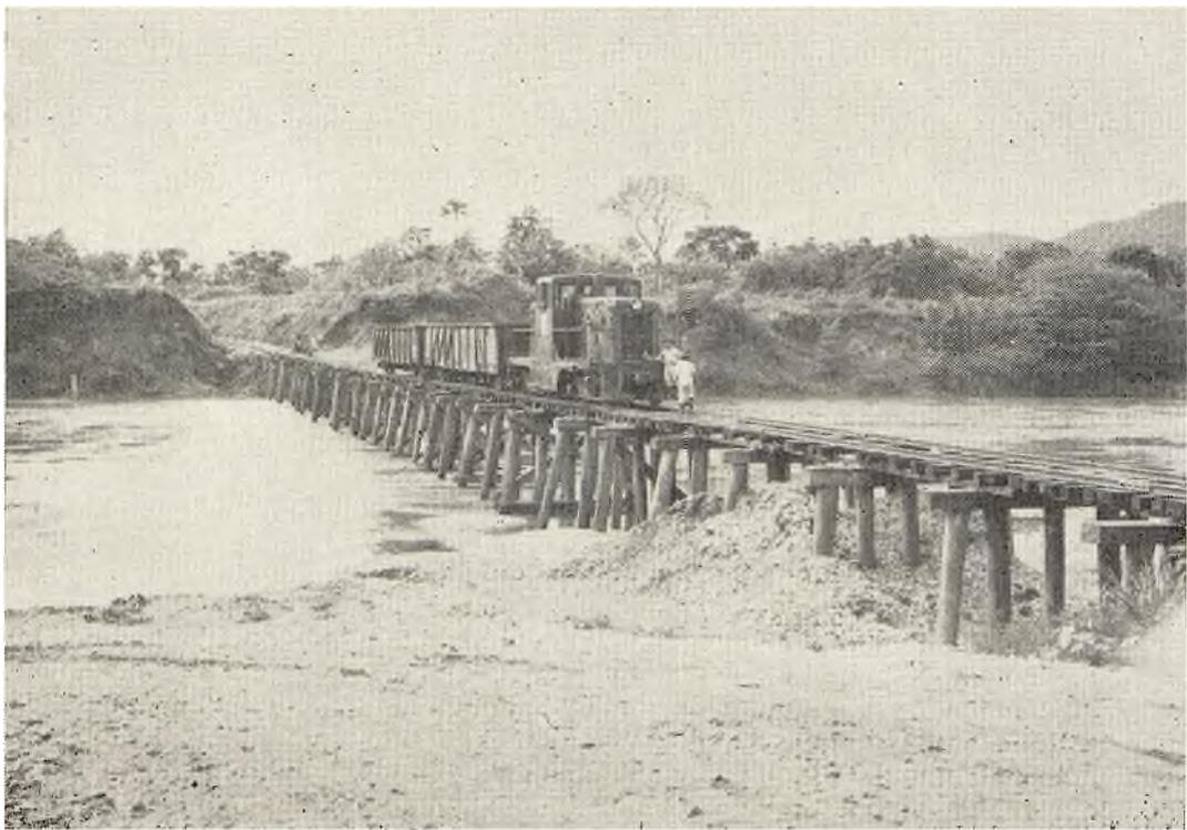
Puente provisional de pequeña altura sobre el río Tacotalpa. Obsérvese que los largueros de madera fueron sustituidos por rieles usados.
