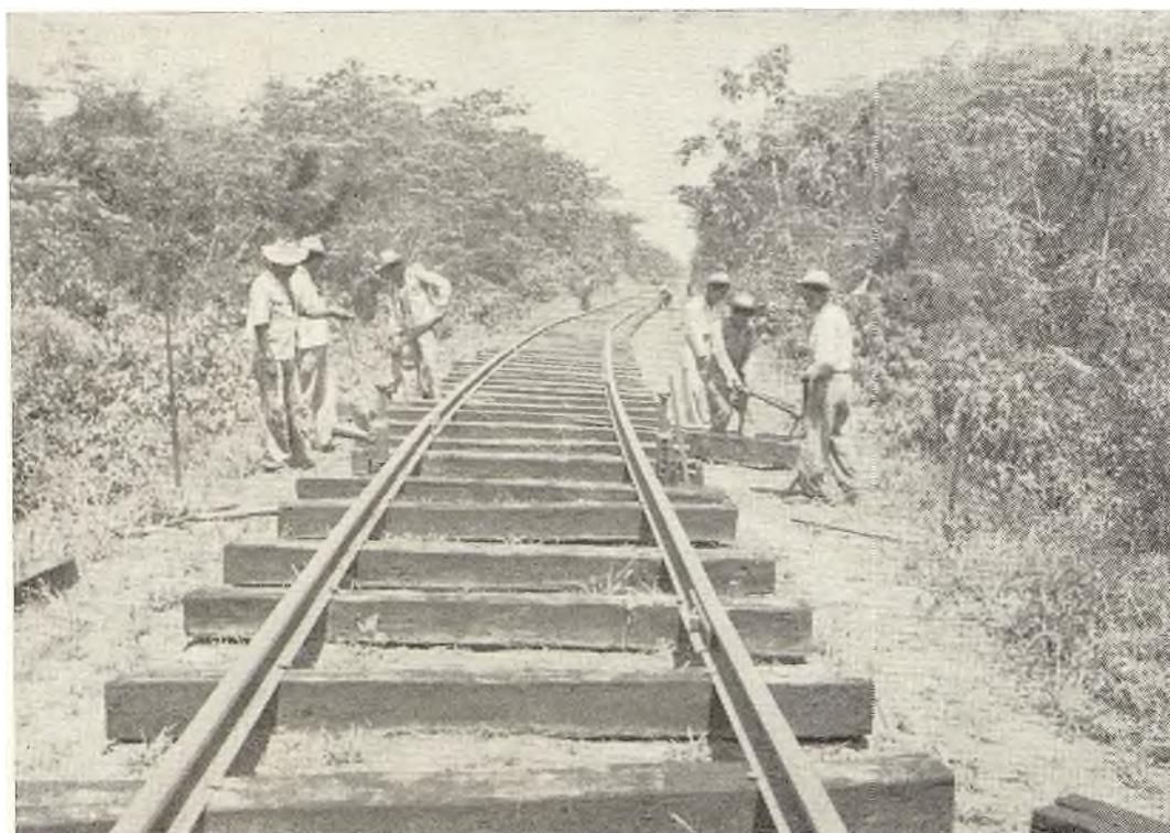
Tendido de vía.—Una cuadrilla completa la dotación de durmientes; la cuadrilla de tendido va muy adelante de ésta.
