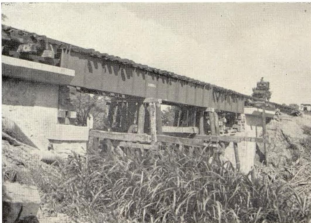
Puente Camoapa, Km. 160.—Estribos en "T" de mampostería de tercera y cubetas de concreto reforzado para contener el balasto. La siguiente etapa y última de la construcción, será descender la trabe de acero para que apoye sobre las coronas de los estribos.
