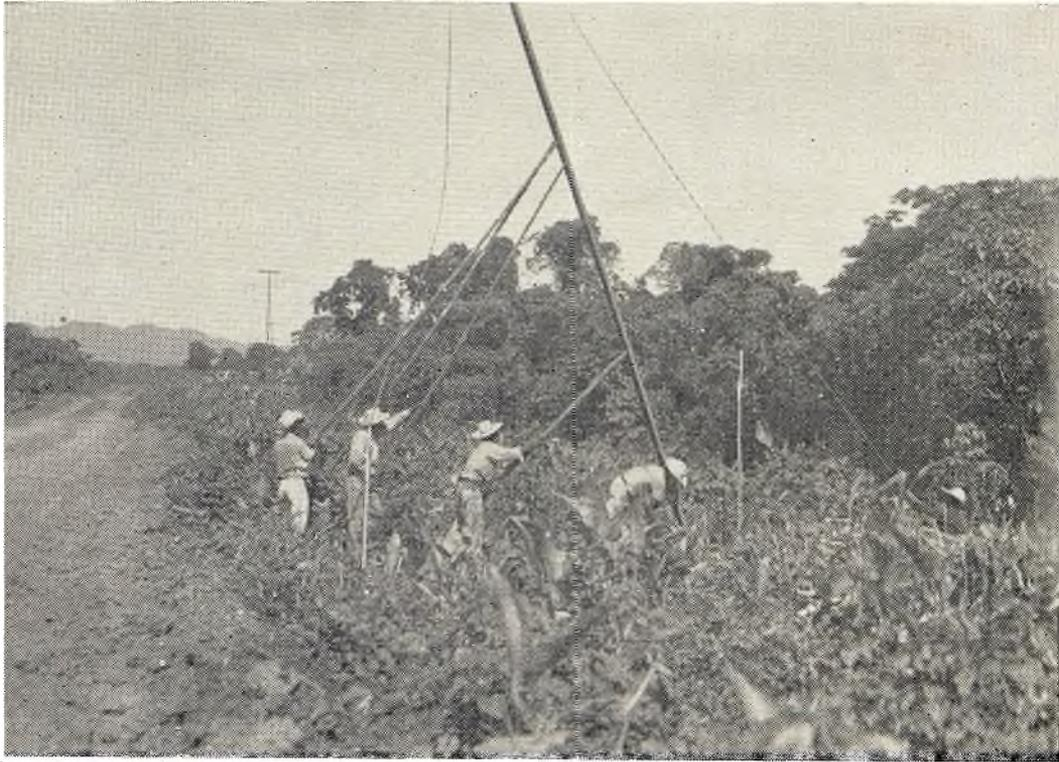
Comunicaciones Telefónicas.—Se dió preferente atención al tendido de la línea telefónica, procurando que su construcción aventajara al tendido de vía.
