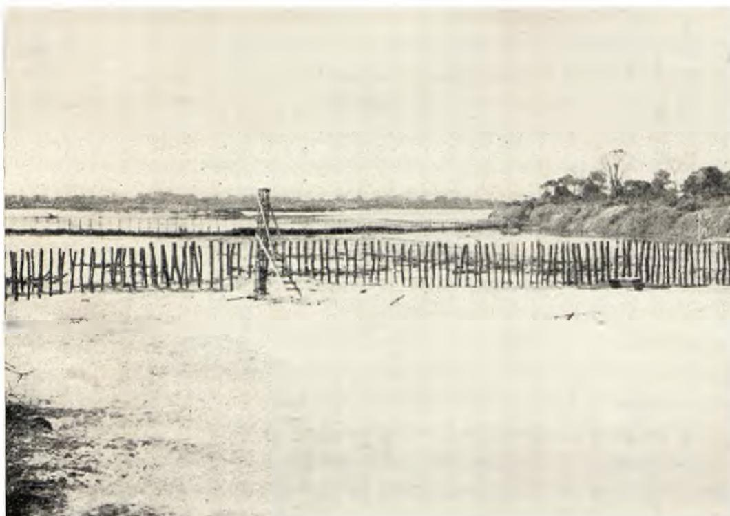
Río Mezcalapa, Km. 145.—Obras previas en la entrada del cauce secundario El Chiflón, para provocar la reducción de velocidad de la corriente durante las primeras crecientes del año y lograr con ello el depósito de los materiales de arrastre e iniciar en esa forma el cegamiento.
