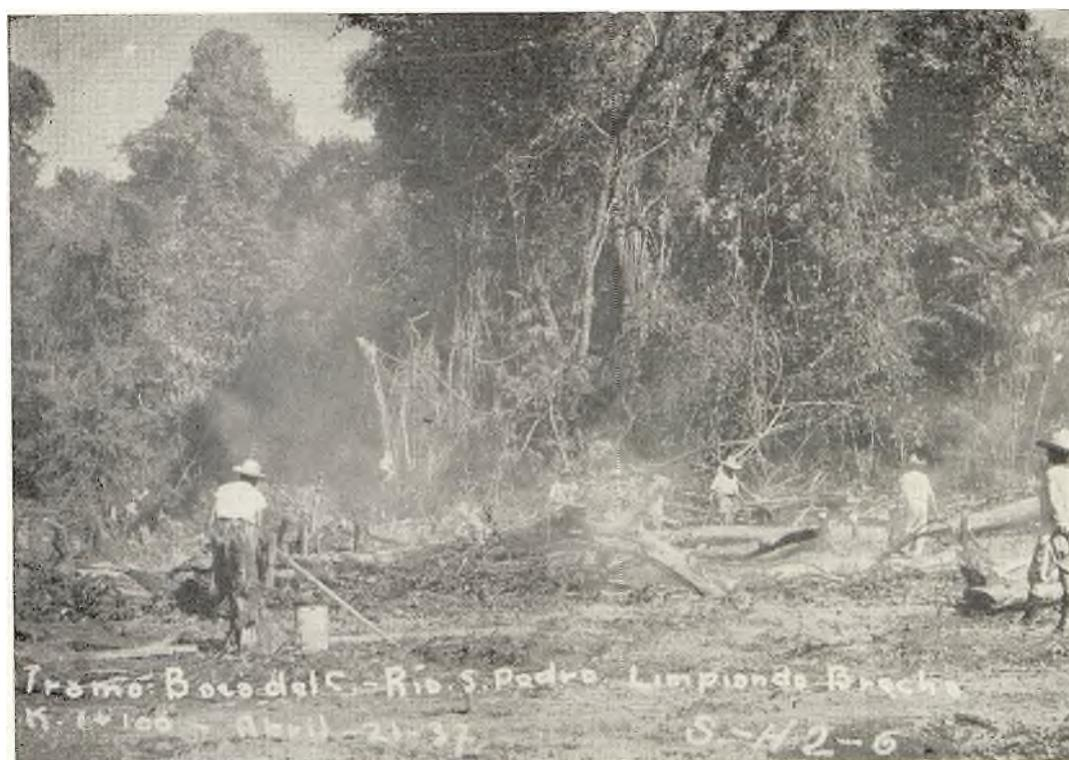
Desmante.—Los árboles desprovistos de ramas y follaje son cortados en trozos para facilitar la maniobra de rodarlos hasta fuera del derecho de vía. Con las ramas ya secas se forman hogueras.
