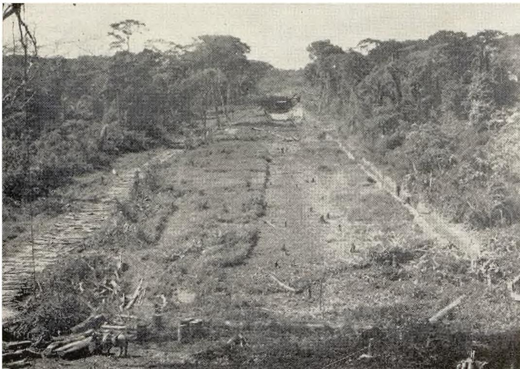
Transportes Terrestres.—Largos tramos de los caminos auxiliares para el tránsito de los camiones y máquinas excavadoras fueron cubiertos con troncos de árboles, colocados transversalmente al eje del camino, uno junto al otro, constituyendo las llamadas marimbas.
