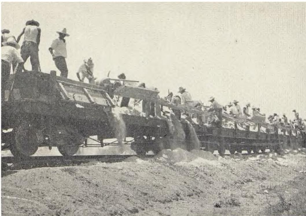
Balasto.—Descarga de material para sub-balasto, de plataformas acondicionadas como gondolas con descarga lateral.
