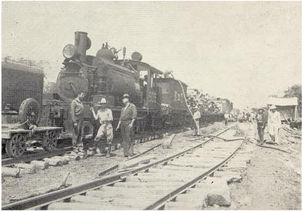
Transportes Terrestres.—Tren de trabajo tirado por locomotora de vapor ligera, procedente de la División del Istmo de Tehuantepec de los Ferrocarriles Nacionales de México.
