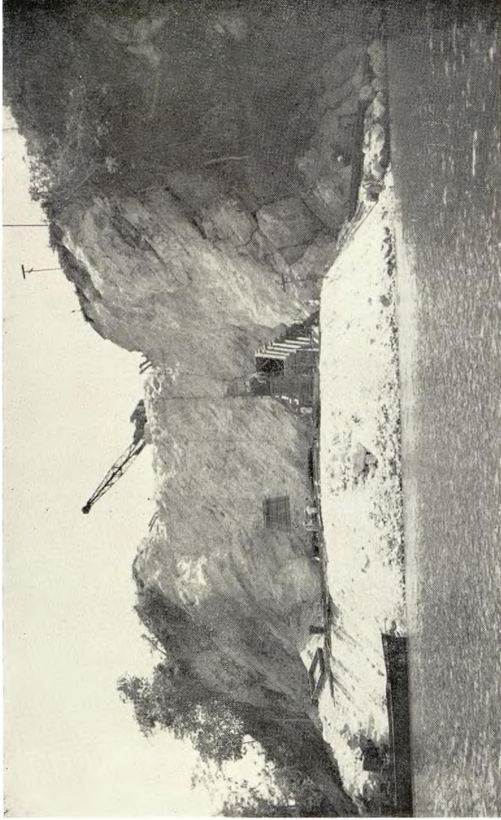
Puente Usumacinta, Km. 396.---Colocación de moldes de madera para el colado de los pedestales de concreto en la margen derecha.
